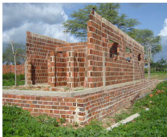
Foto 17 – Construção do prédio
