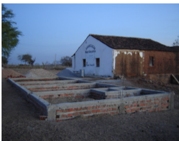
Foto 16 – Construção do prédio
